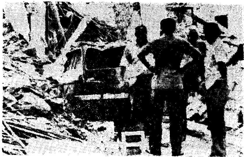
MIEMBROS DE LAS fuerzas de rescate frente a una de las casas destruidas por el terremoto que asoló ayer a la localidad argentina de Caucete. (Exclusiva para EXCELSIOR, de "Clarín", de Buenos Aires)
