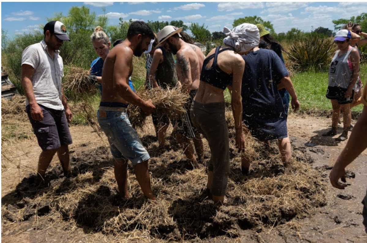
Taller de bioconstrucción. Fotografía cedida por “Damarka”
