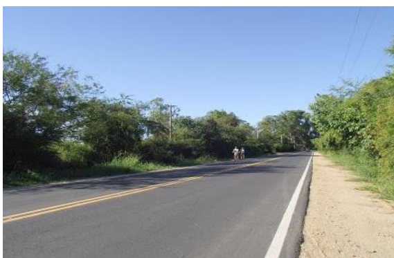
Figura 46: Tramo de la av. Juca Batista entre Chapéu do Sol y Belém Novo
