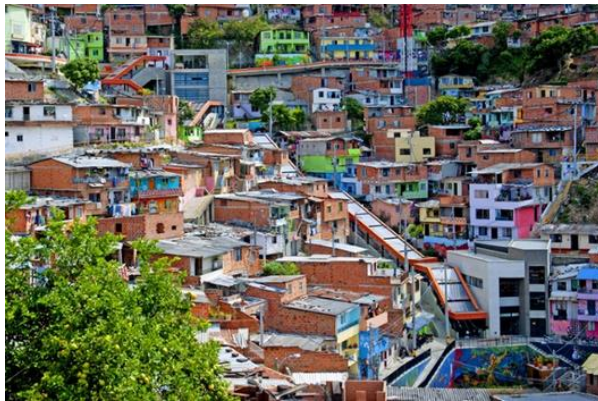
Figura 27: Vista de las escaleras mecánicas, intervención urbana y arte social: Comunidad 13, San Javier
