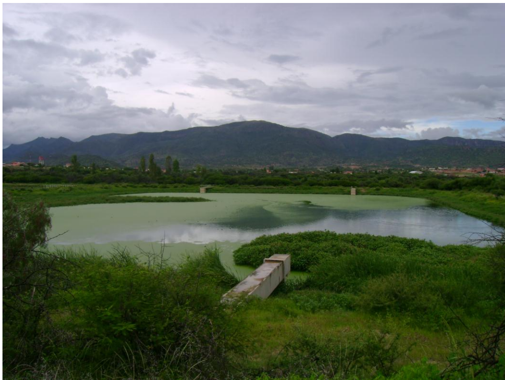
Vista actual de las lagunas de oxidación, en estado de sobresaturación.
