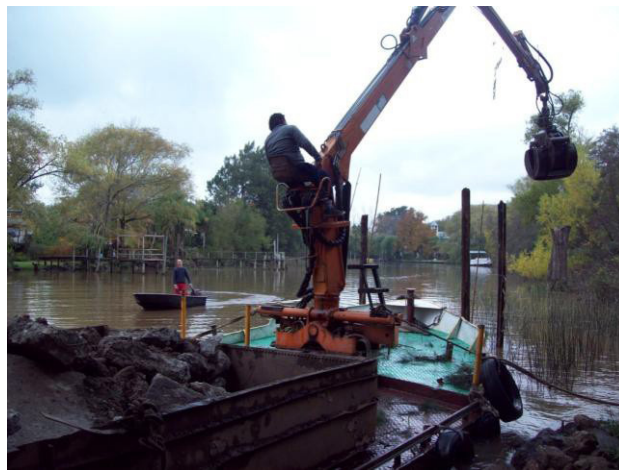
Imagen 16. Clavando los palos del muelle de Itekoa.
