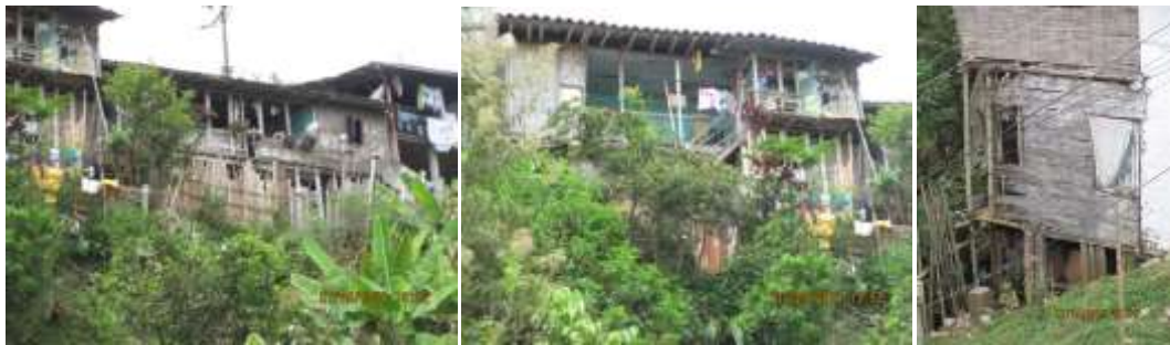
Casa urbanas en zona de ladera. (Fotos: J. Cañas A.)
