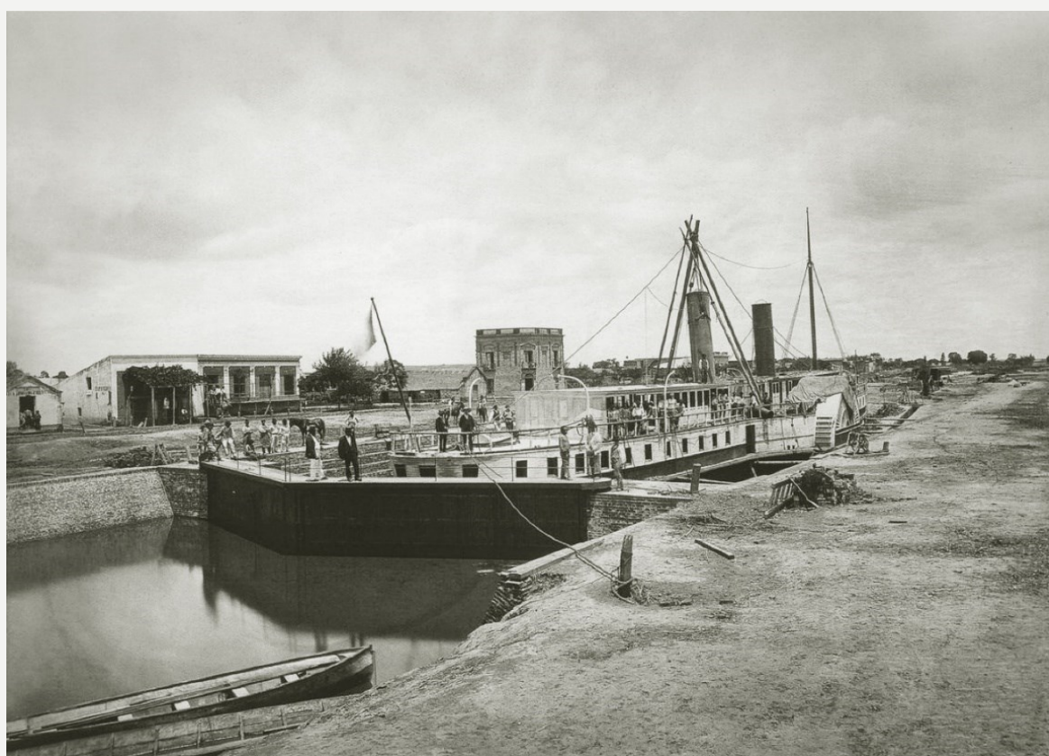
Figura 9.2. Dique seco de San Fernando, 1877.
