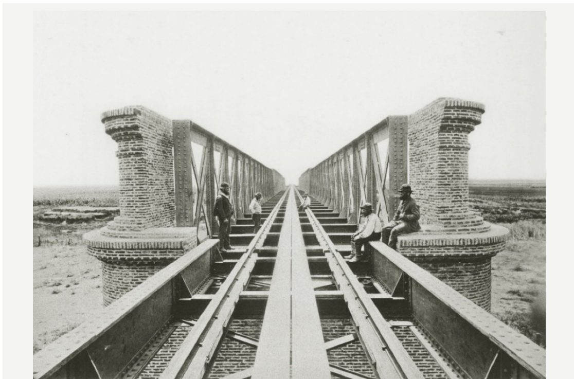
Figura 9.1. Puente sobre el río Arrecifes, ferrocarril de la provincia de Buenos Aires, 1889.
