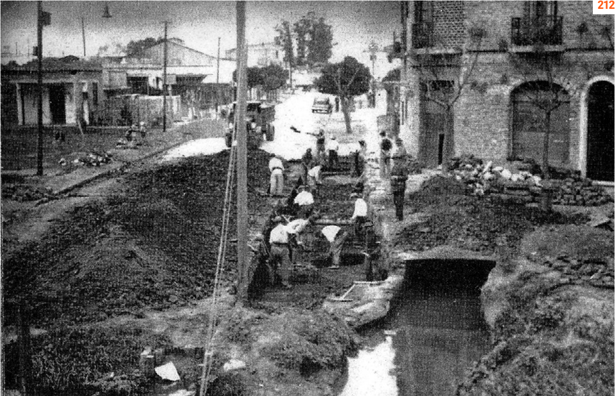
212 Calle French Entubamiento zanja, vista del F.C.O hacia calle Rivadavia, al iniciarse las obras
