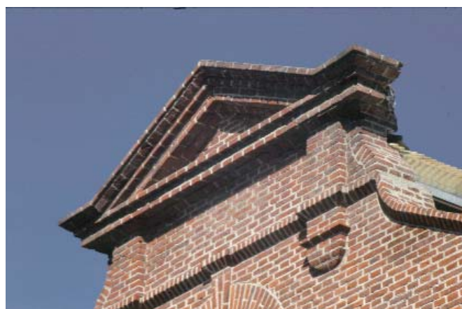
Detalle de la mamposte- ría del Edificio del Re- torado de la Universidad Nacional de Lanús.
