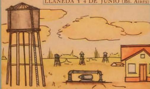
56 pozos semisurgentes con 40 electrobombas y 16 Diesel bombas. Dos depósitos enterrados, uno sobre nivel y seis elevados. 677.000 metros de cañerías y 67.000 conexiones. Su costo se eleva a \$ 14.779.490.
