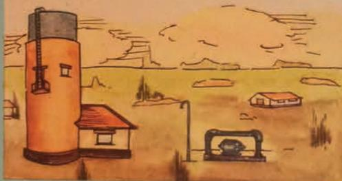
Toma de agua del Río Paraguay, simple bombeo por tres electrobombas, un depósito elevado. 55.000 metros de cañerías y 1.900 conexiones. Cloacas: 550 conexiones y 22.300 metros de cañerías. Su costo se eleva a \$ 150.000.
