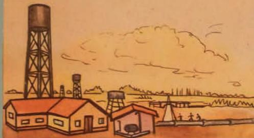
Cuatro pozos semisurgentes con sendas Diesel bombas. Depósitos (Enterrado y elevado). 56.900 metros de cañerías y 4.300 conexiones.
